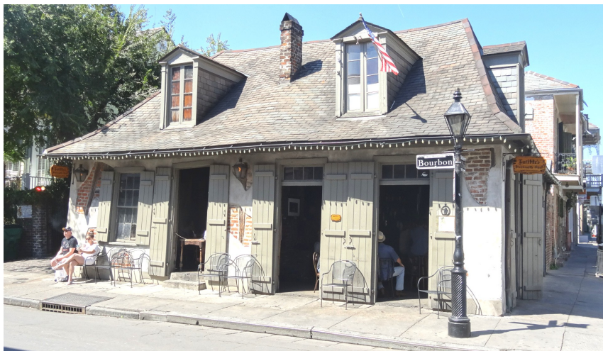
Maison de Jean Lafitte , bourbon Street, quartier Français de la Nouvelle Orléans
